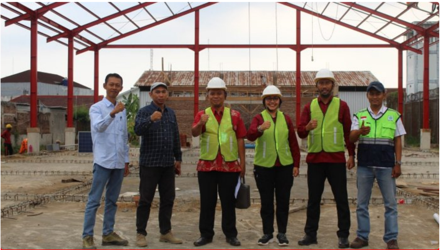
UKPBJ Setwil Jateng Tinjau Progres Pembangunan Gudang Basan Baran Rupbasan Purwokerto
